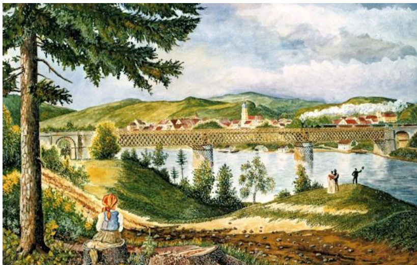
Prvi leseni železniški most čez Dravo v Mariboru po sistemu Howe, zgrajen leta 1846, je bil dolg 190 m in izdelan iz macesnovega lesa. Pogled s Pobrežja. (akvarel po starih grafikah: Sepp Tezak, 1985)
